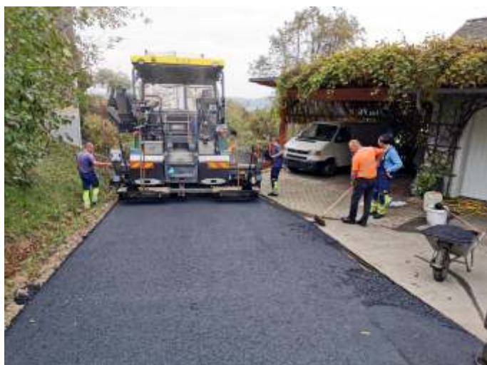
Asphaltierung des Plankweges und des Pölzweges
